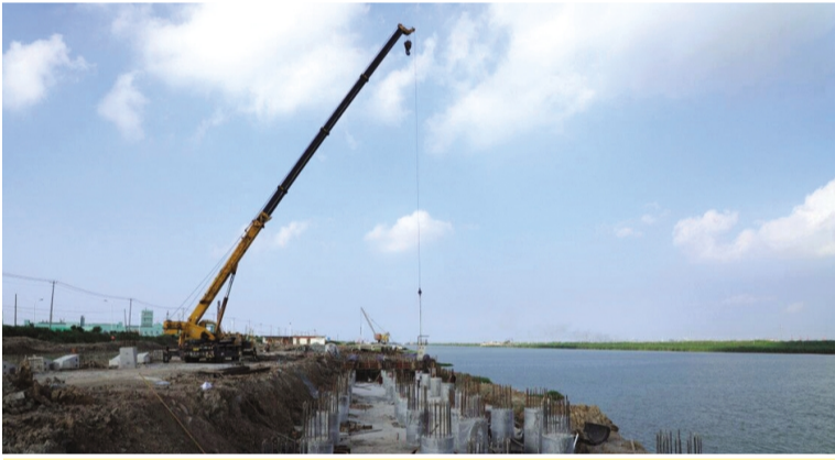
自八月份以来,灌西投资公司加强五灌河码头二期扩建工程的夏季施工管理,全面总结前期各节点工期施工经验,“干两头,休中间”,克服高温烈日天气影响,以“务实、高效”的精神加快工程进度。截止目前,工程进度完成73%,现已进入平台施工阶段。(张明建)
