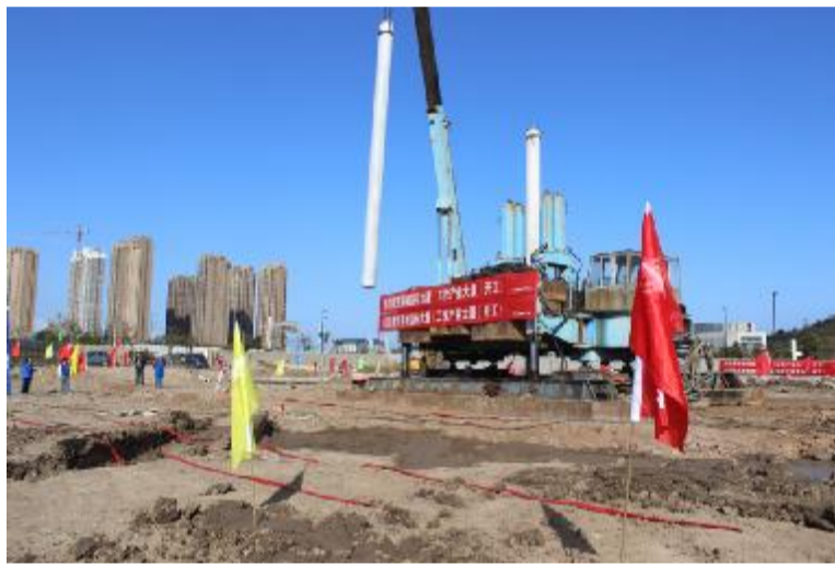
经过前期紧张筹备，11月17日，工投产业大厦（港城国际）工程打下第一桩，标志着该项目正式开工建设。
